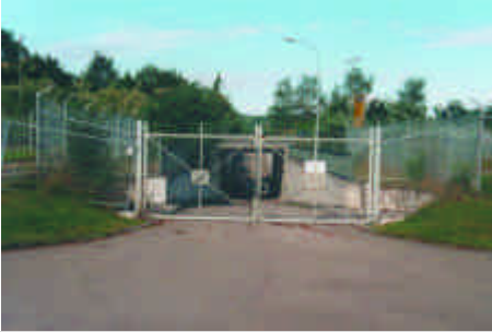
Unterführung der B 17 Panzerstrasse
